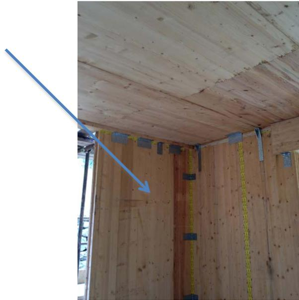
Figura 9 - al piano terreno sarà posizionato un cappotto interno in cartongesso
