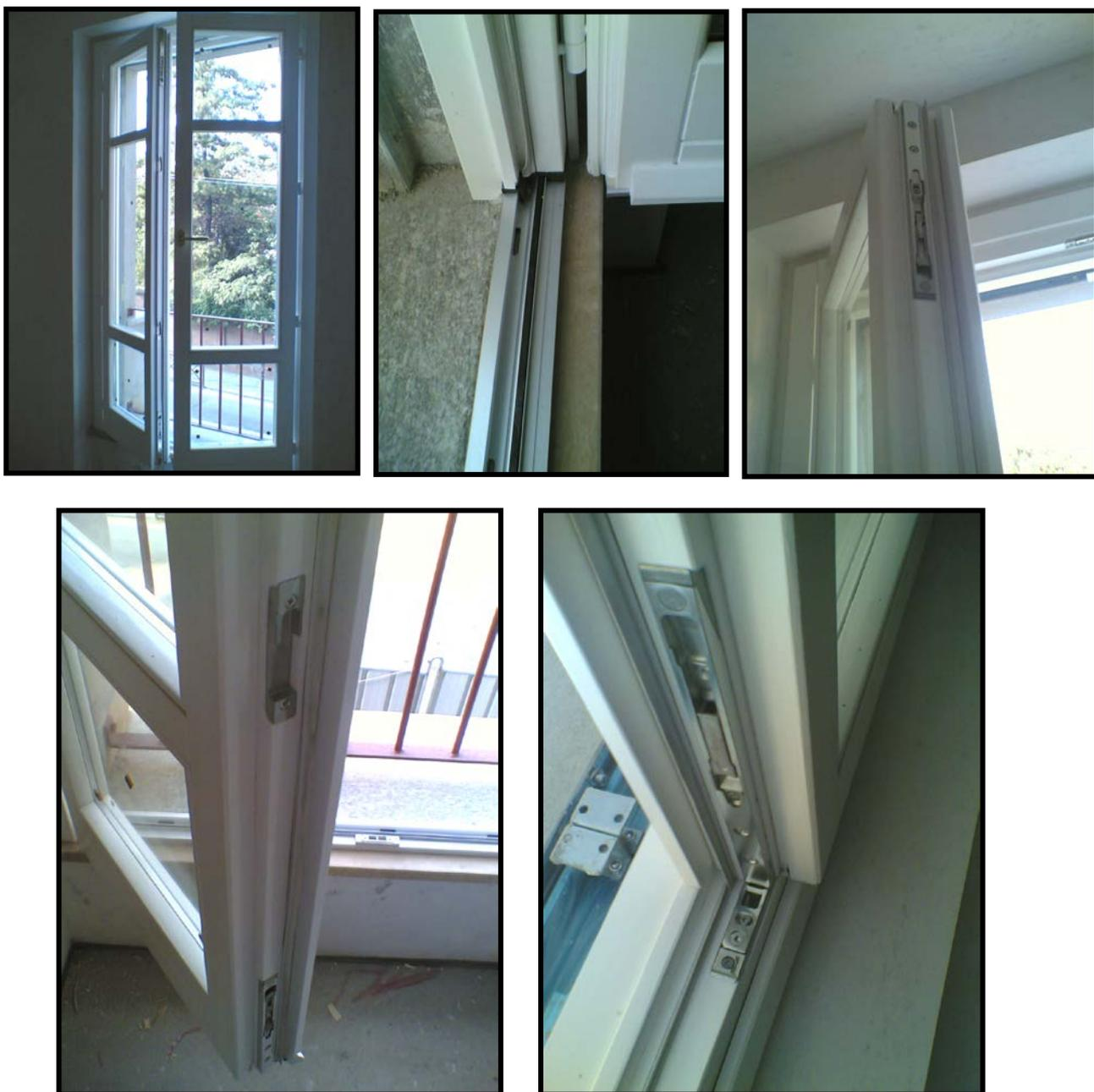
Figura 17 - serramento in legno lamellare con 6 punti di chiusura e 8 cerniere di tenuta
